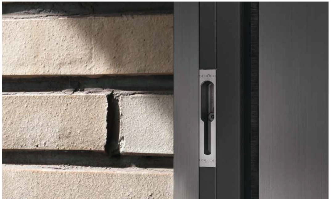
Beschlagsoption mit flächenbündiger Verriegelung im Blendrahmen Fittings option with flush-fitted locking in the outer frame
